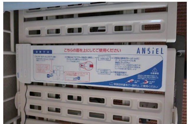
機器設置の様子
